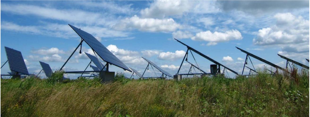
Los sistemas de seguimiento activo de 1 eje de DEGER permiten el aprovechamiento óptimo de toda la energía de radiación incidente y son compatibles con todos los módulos solares del mercado. Se consiguen incrementos del rendimiento de hasta un 30% para todas las aplicaciones FV.
